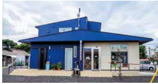
昨年11月、道路の拡張工事に伴い、道路を挟んで反対側に移転。店舗外観を青色にリニューアルした。
