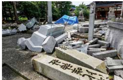
穴水町内の神社も倒壊し、手つかずのままになっている
