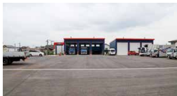
災害時のヘリポートとしても機能する防災センター
